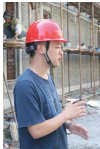
因为刚泰置业土建工程师王东华在南汇总部大楼改造工地上工作
